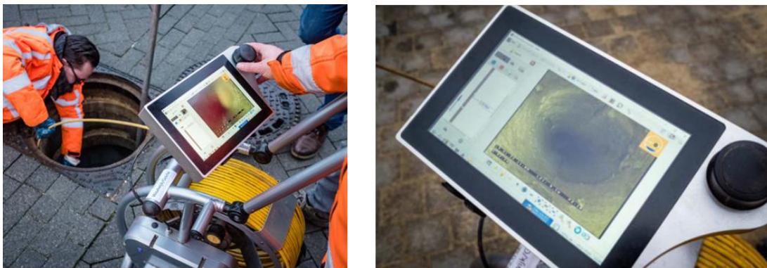
Figur 3: TV inspektion med et skubkammera. Kammeret føres ind i indløbskanalen, hvorfra der kan optages film og tages billeder.
