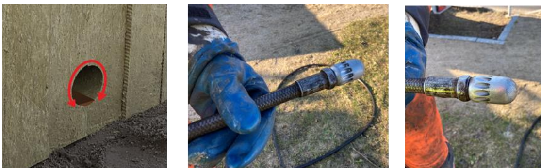
Figur 4: Spuling foregår i Rockflowmagasinets indløbskanaler (TV). Spuling sker med brug af en drændysse, med 15 grader bagudrettede dyser (Midt og TH).
