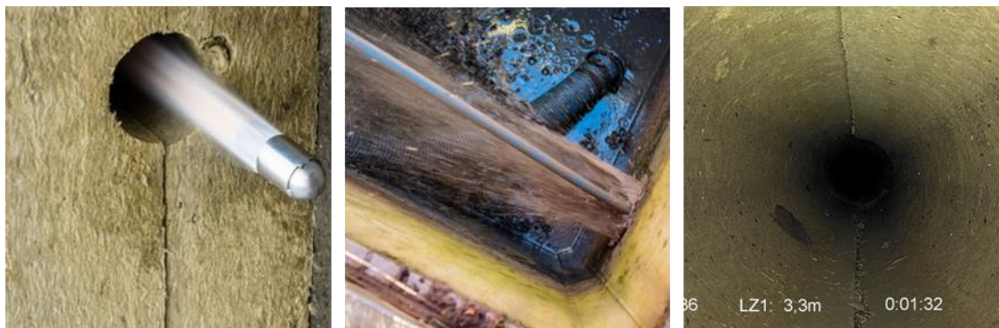
Figur 5: TV: Spuling af Rockflow indløbskanaler med drændysse. Midt: Slammet fra Rockflow kanalerne spules bagud til brønd, hvor det suges op. TH: Inspektion af indløbskanaler efter spuling.
